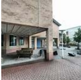
Der komplette Gesamtschulkomplex wird bei laufendem Betrieb schrittweise saniert. 14 Millionen Euro kostet die Erneuerung der Schul- und Sportstätten. Im Oktober 2012 soll alles fertig sein. (Bild: Krempin)
